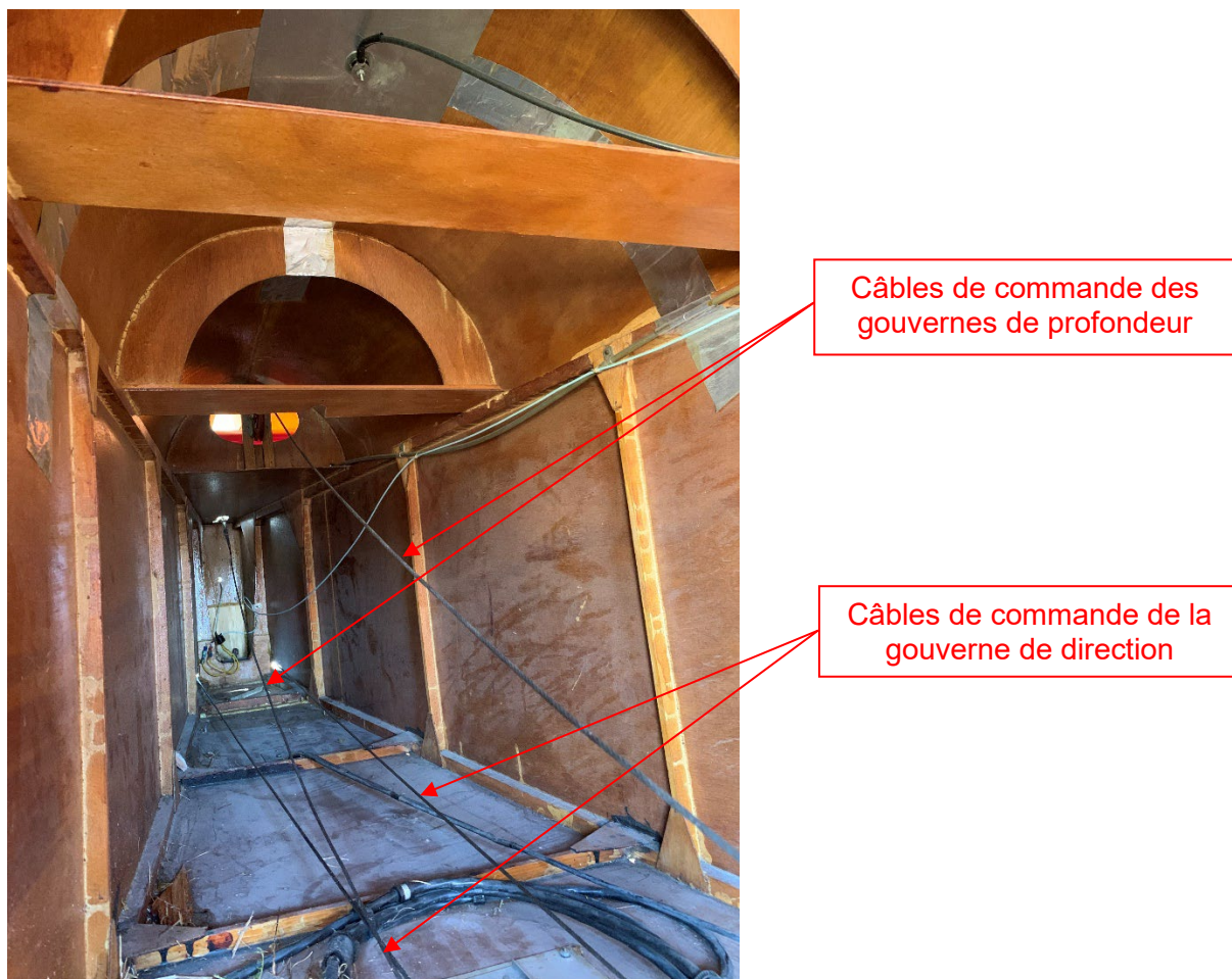
Figure 19 : intérieur de la poutre de queue Source : BEA
